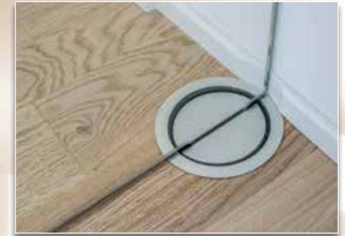
Detail: Bodeneinlasselement: GTB 5
