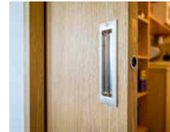
Türblatt verschwindet in der Wand.
